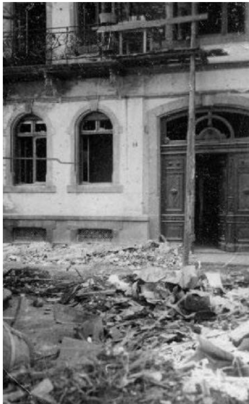
SVQ I72 Imprimerie N°04, 05, 06_c - Fortschritt - 1945
