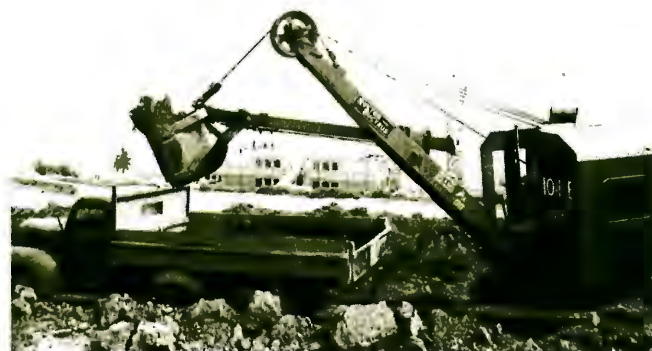
Riesige Lastwagen transportieren den überflüssigen Boden
