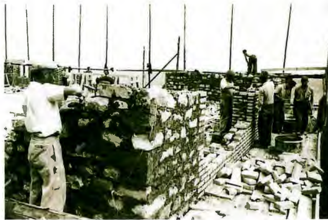
Rund 17000 Kubikmeter Steine und Ziegeln wurden verwendet
