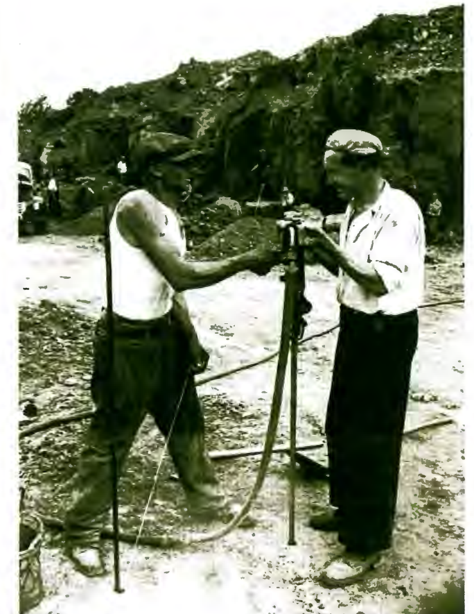
Das Bohren der Sprenglöcher
